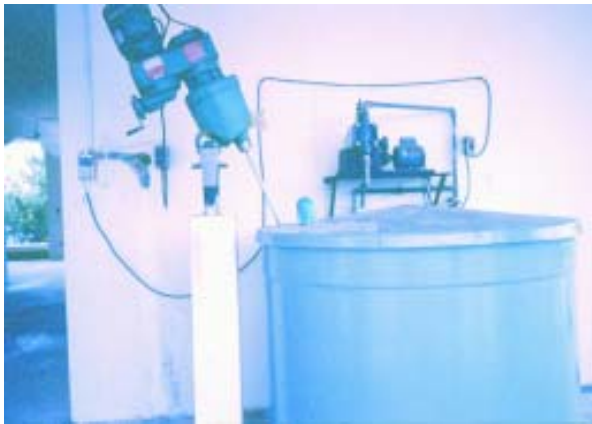
Figura 1-16. Sistema de dosificación por bombeo (1)
