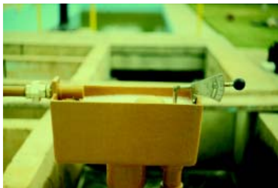
Figura 1-20. Dosificador por gravedad de orificio de carga constante (1)
