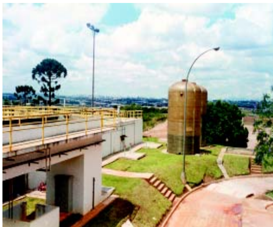
Figura 1-9. Tanques de plástico reforzados con fibra de vidrio (1)
