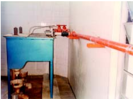
Figura 1-18. Dosificador de orificio de carga constante (I)
