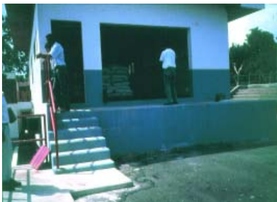
Figura 1-28. Entrada al almacén de sustancias químicas (1)
