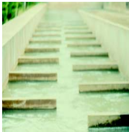
Figura 3-11. Floculador de pantallas de flujo horizontal (7)
