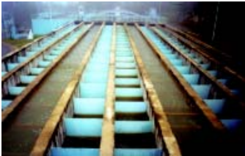
Figura 3-21. Floculadores de pantallas de flujo vertical (7)
