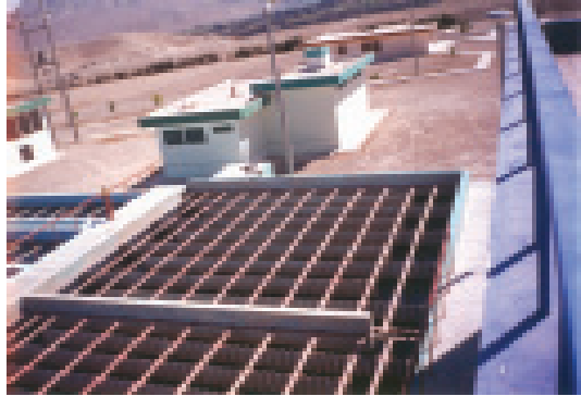
Figura 3-2. Floculador de pantallas de flujo horizontal (7)
