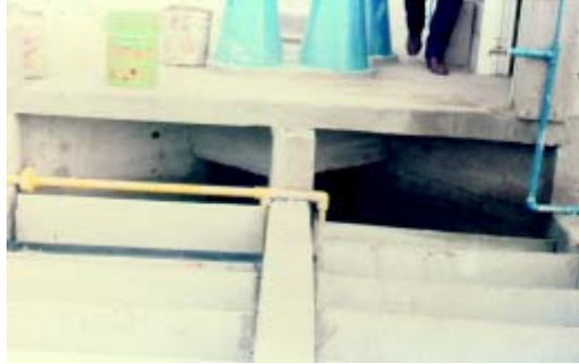
Figura 3-20. Floculador de flujo vertical (7)
