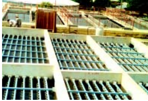
Figura 3-13. Floculador de pantallas de flujo horizontal (7)
