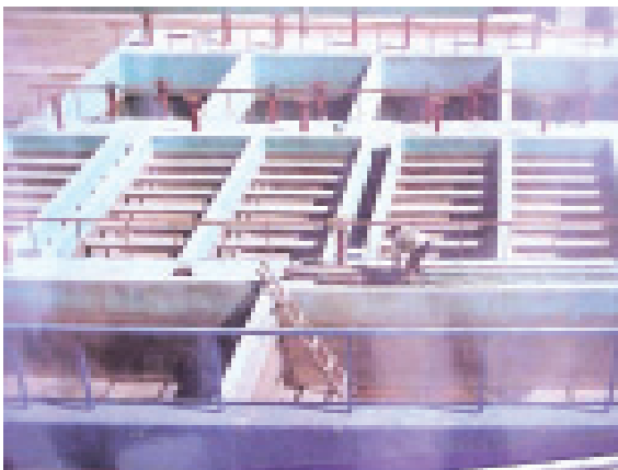
Figura 3-3. Floculador de pantallas después del sismo (7)
