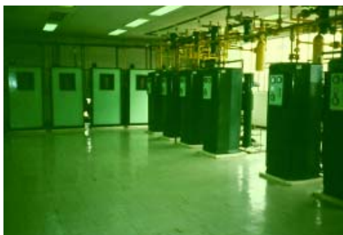
Figura 6-28. Evaporadores para operar con cloro líquido (2)
