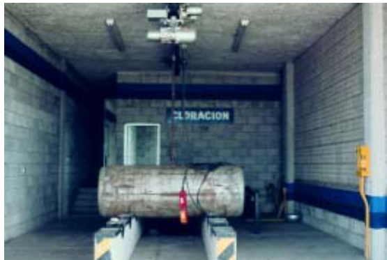
Figura 6-4. Forma de almacenar cilindros de una tonelada (2)
