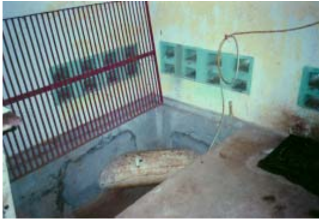
Figura 6-18. Punto de aplicación en la tubería (2)
