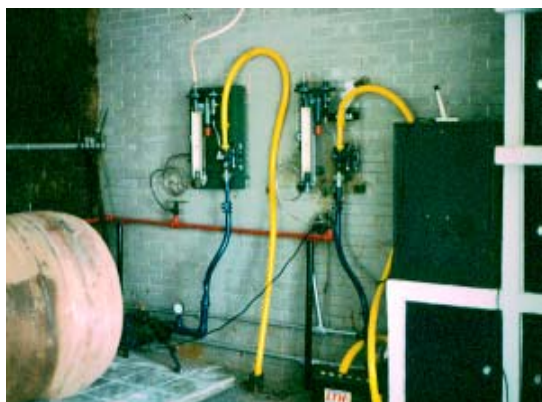
Figura 6-22. Cloración al vacío, equipos de pared (2)
