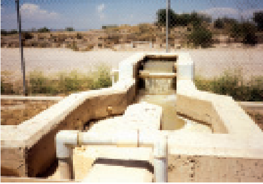
Figura 2-21. Vertedero rectangular como mezclador (4)
