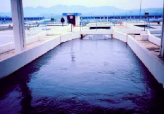
Figura 2-12. Canaleta Parshall para 1,0 \text{ m}^3/\text{s} (4)
