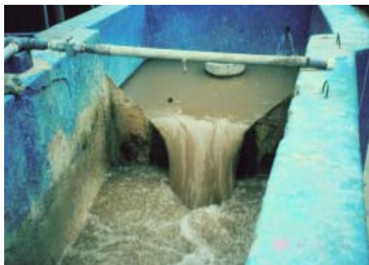
Figura 2-23. Defectos en el diseño de un vertedero triangular como mezclador
