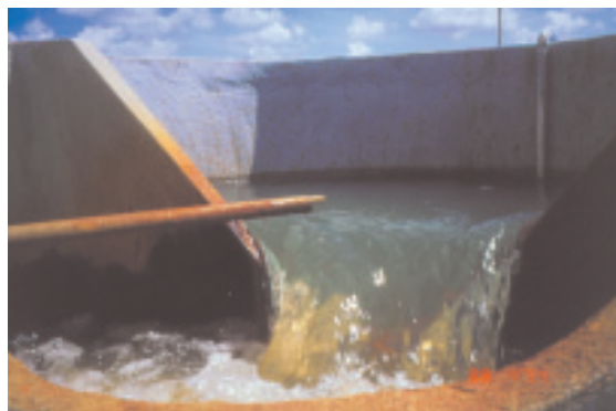
Figura 2-22. Vertedero triangular como mezclador
