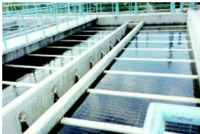
Figura 4-20. Sistema de recolección mediante tuberías perforadas (4)
