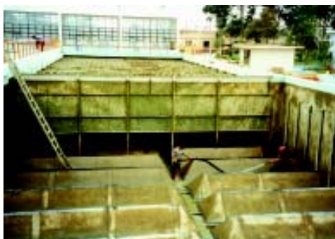
Figura 4-38. Decantadores convencional y laminar en serie (4)
