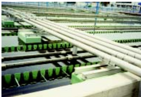
Figura 4-28. Sistema CLARIVAC de extracción de lodos
