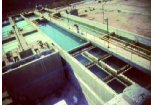
Figura 4-39. Decantadores convencional y laminar en serie (4)
