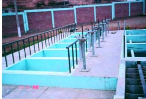
**Figura 5-1.** Batería de filtros de tasa declinante y lavado mutuo (1)
