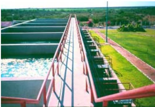
**Figura 5-2.** Baterías de filtros de tasa declinante con galería de tubos (1)
