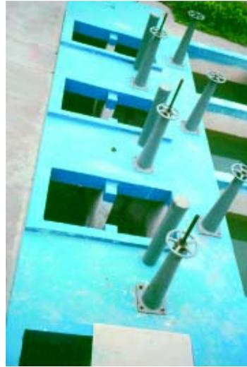
**Figura 5-29.** Canales de agua filtrada destapados
