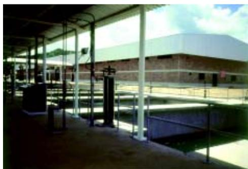
**Figura 5-4.** Batería de filtros de 1,0 m<sup>3</sup>/s de capacidad (1)
