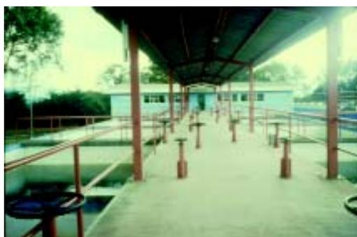
**Figura 5-5.** Sistema de filtración de tasa declinante y lavado mutuo (1)
