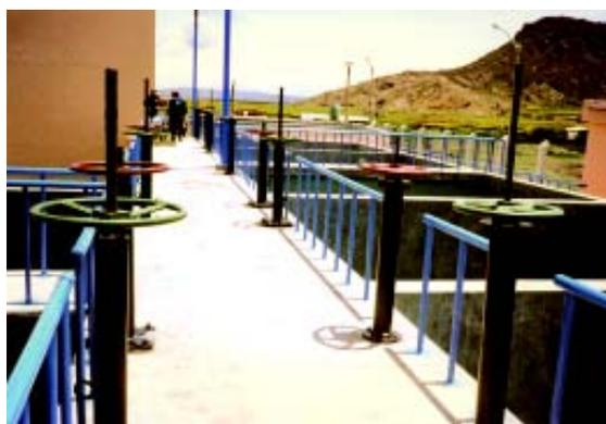
**Figura 5-32.** Batería de filtros de tasa declinante y lavado mutuo
