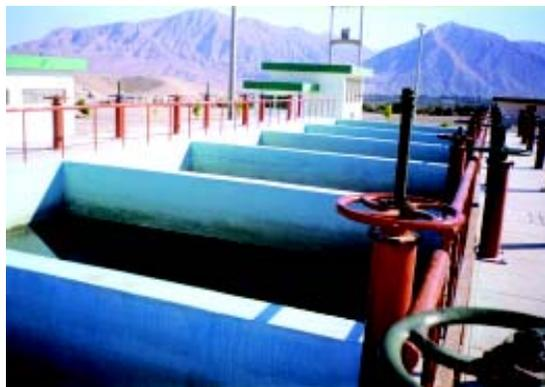
**Figura 5-30.** Batería de filtros de tasa declinante para un caudal de 250 L/s
