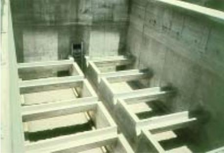
**Figura 5-13.** Canal principal central y canaletas secundarias laterales (1)
