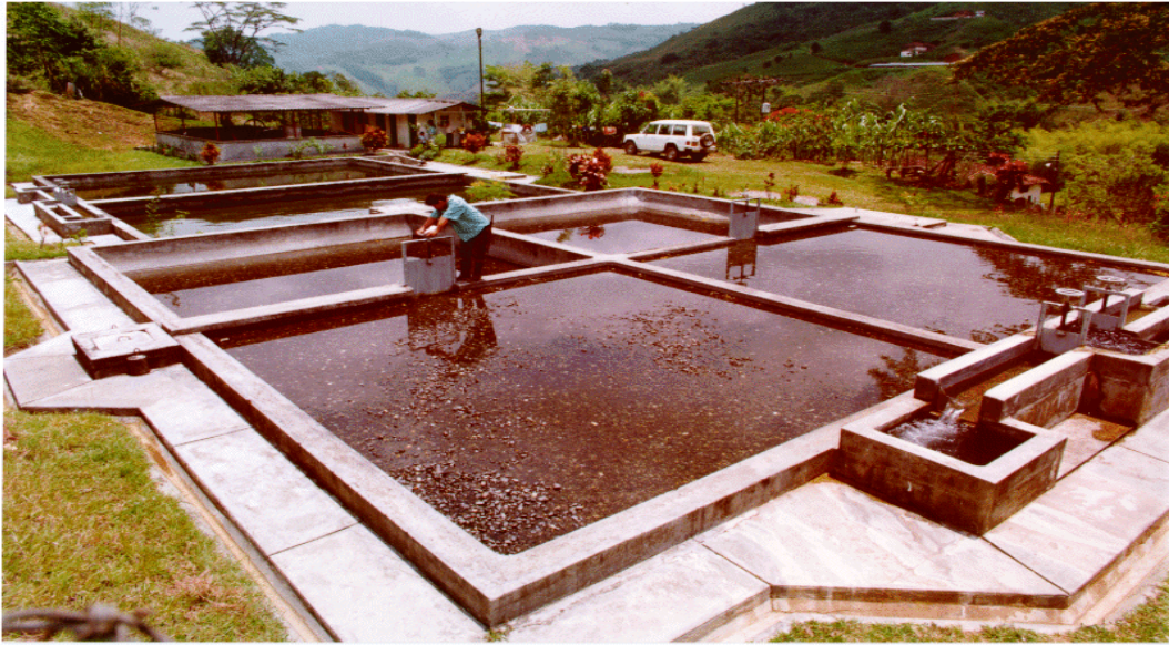
Figura 1.3 Planta de tratamiento por Filtración en Múltiples Etapas, FiME, construido en la Zona Cafetera. Corregimiento de Salónica, Municipio de Riofrio, Colombia. 1997.
