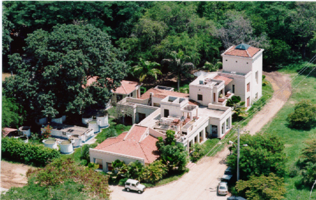
Figura 5.2 Estación de Investigación y Transferencia de Tecnología de Cinara en Puerto Mallarino.
