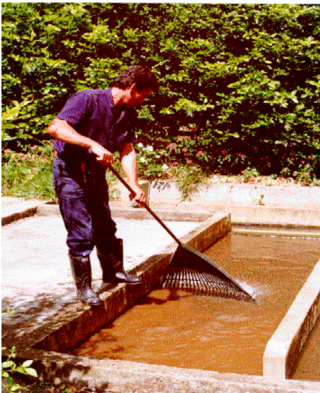
Figura 3.3 La salud de una comunidad depende del grado de entrenamiento y motivación del operador; también del seguimiento y apoyo brindado por la comunidad y las instituciones de soporte. Planta FiME, Filtro Grueso Dinámico, Colegio Colombo Británico, Cali, Colombia, 1997.
