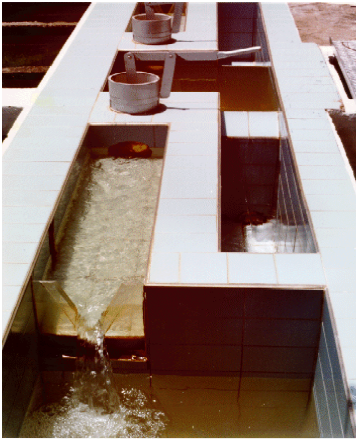
Figura 9.4 Estructura de entrada a unidades de filtración gruesa. Universidad Javeriana, Cali, Colombia, 1997.
