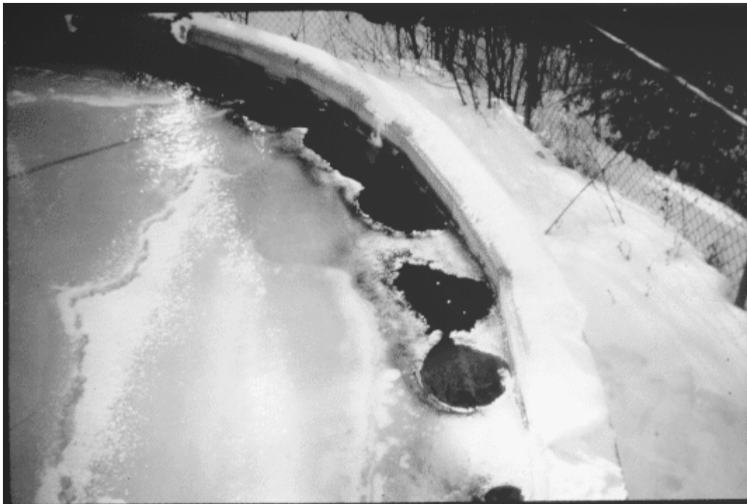
Figura 4.5 Filtro lento en arena congelado, ubicado al Norte de los Estados Unidos.
