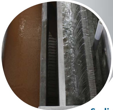
Sedimentación de flujo ascendente con manto de lodos
