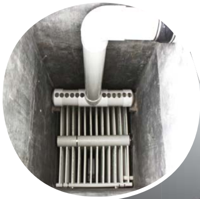
Filtración rápida de arena en múltiples capas
